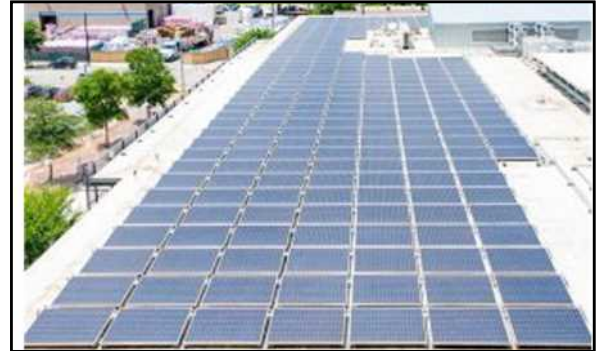
Exemple panneaux posés à plat.
